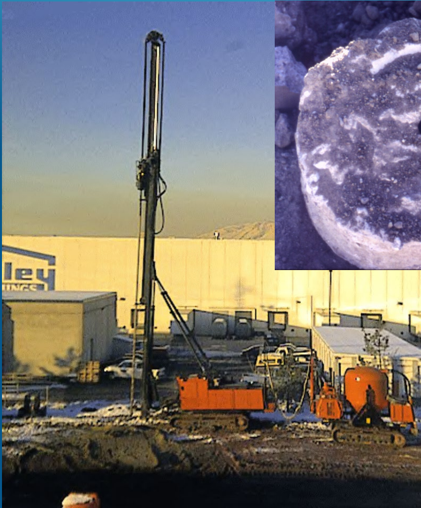
Lime Cement Columns
