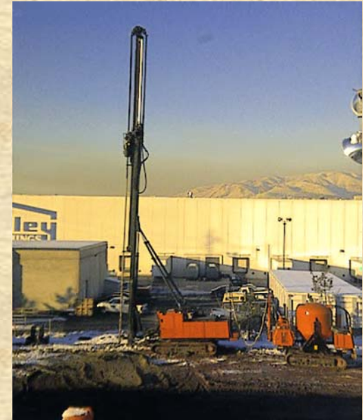
Lime Cement Columns
